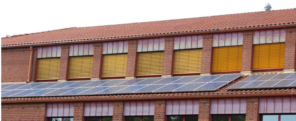
Die Fotovoltaikanlage am LMG, 2016.
